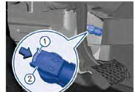
Batterie Hauptschalter im Fahrerfußraum
