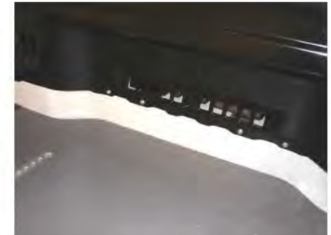
Luftausströmer in den Laderaum.
